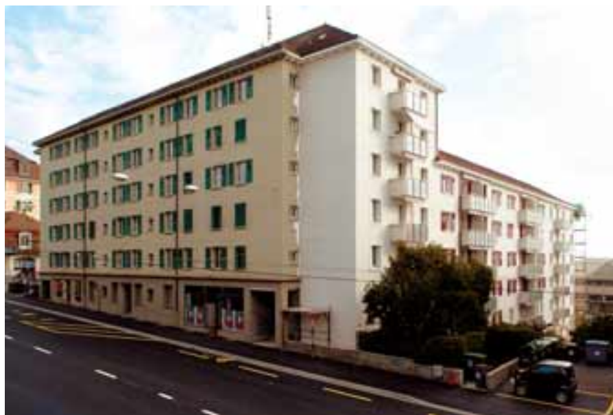
Couchirard - rénovation - octobre 2003
