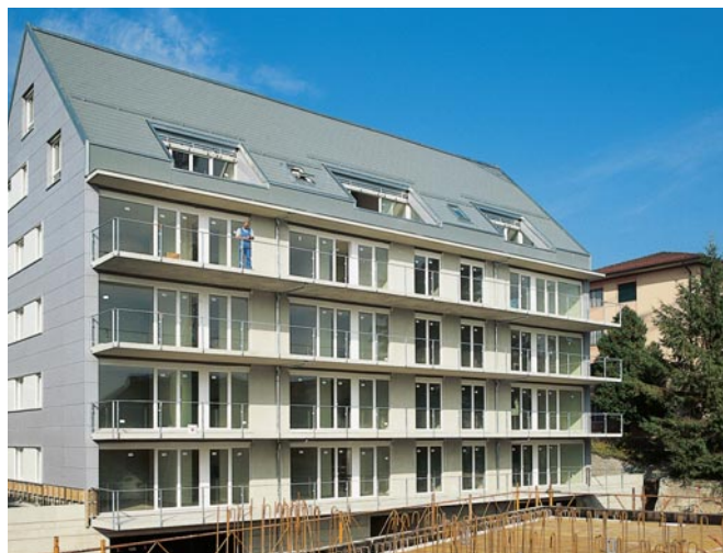
Pully IV - Liaudoz - Bâtiment A - octobre 2002
